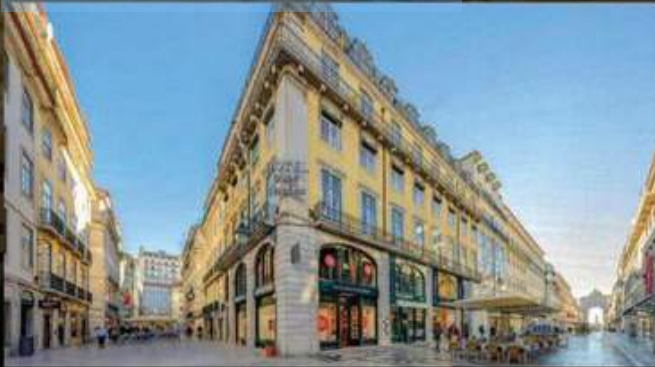
DUAS NAÇÕES ** LISBON CITY CENTER
